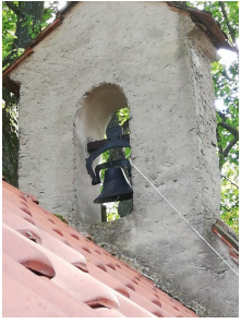
zvon zavěšený ve zvonici ovládaný lanem
